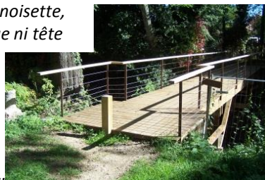
Nouvelle passerelle de Paillet
